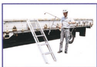
④ 本体のセット完了後手摺を取付ける
