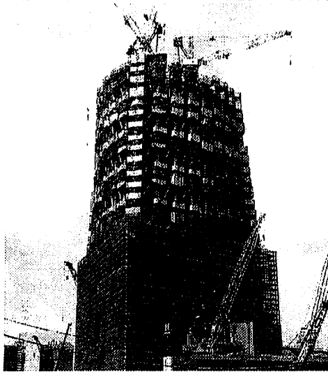
外塔ユニット足場
