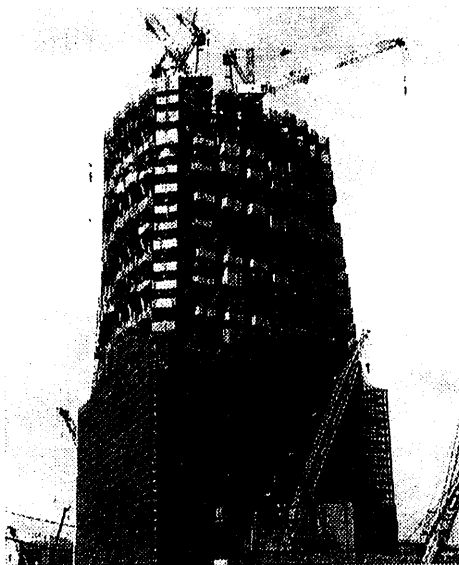
外塔ユニット足場
