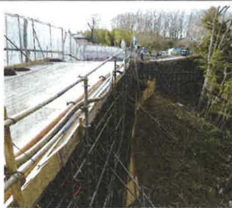
仙台市発注工事で採用された「法面8号」
