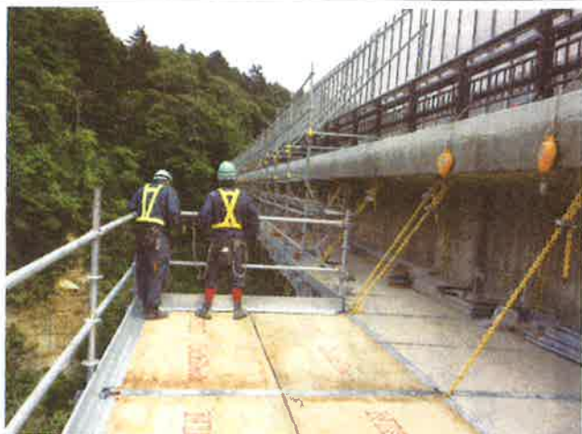
見学会のためにデモで短時間で仮設した吊足場
