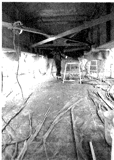
快適な作業空間を確保
