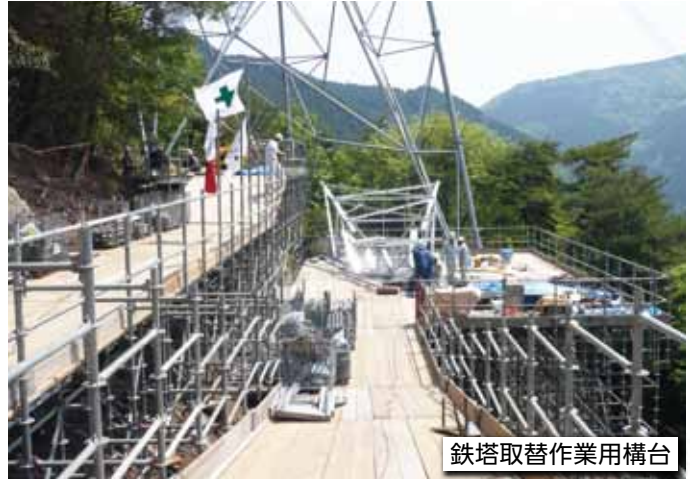
重機作業及び資機材荷取り構台
