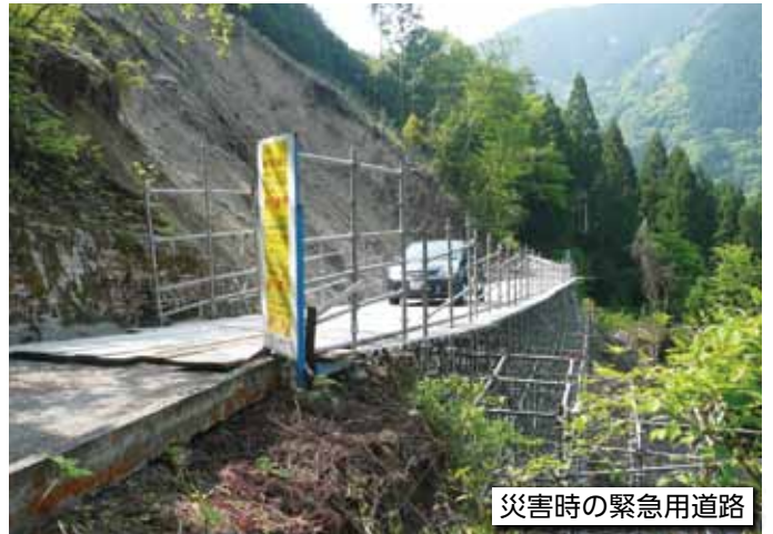
鉄塔取替作業用構台
