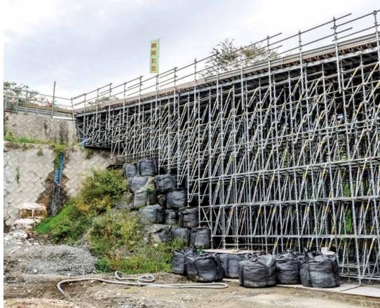
調整池のよう壁再整備工事現場へ重機がアクセスできるための仮設通路、仮設構台として法面マルチアングル工法が150t採用。池の中心に作業構台が設置できたことで、作業効率が向上した。
