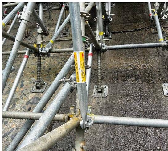
放流設備の改良工事。ダム堤体に新たな放流設備を設置するため、掘削用重機バックホウで掘削し大きな穴を開けるための作業用ステージとして法面マルチアングル工法20tが採用。
