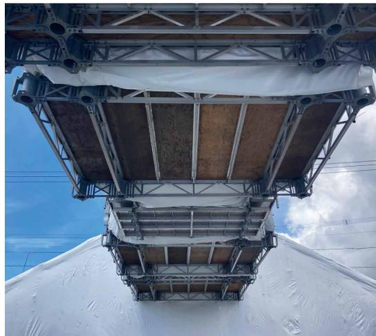
嘉島歩道橋は橋長20.4m(延長23.8、)幅員2mの単径間2主鉄桁橋。1993年架設から30年余が経過して経年劣化で鋼部材などに腐食が生じているため、塗膜剥離と素地調整および塗装作業にクイックデッキライトとクイックラップが採用。採光性が高く、明るい環境で安全に作業ができたと評価を受けた。
