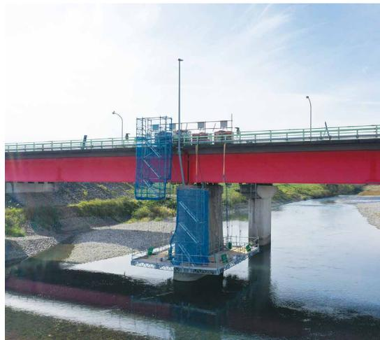
橋脚の耐震補強工事。クイックデッキを UpPro を使って昇降させることで水位変動に対応ができる。県内の河川管理者からの評価も高く、似た環境の橋梁補修は発注前からクイックデッキでの施工計画で発注。
