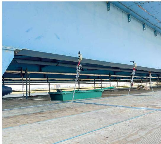
老朽化に伴う配水管の取り替え・更新作業。配水管の長さが4mで、橋上から橋の下に取り込むのにチェーンピッチが広い吊足場という事で、チェーンピッチが2.5m確保出来るクイックデッキライトが採用となった。施工延長200mに対し、約1400㎡が採用。
