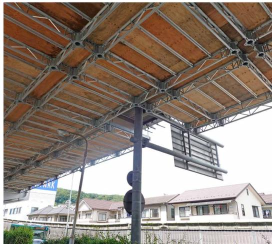
国道2号線と宮島街道との交差部の橋梁補修工事。橋梁下部は月極駐車場で工事中も一般車の出入りおよび駐車車両があるため、先行床吊足場のクイックデッキライトを採用。街灯や道路看板の部分はクイックデッキライトに段差をつけて施工した。
