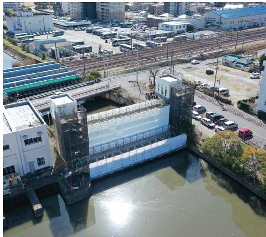
水門と階段の塗膜を除去し、塗り替え作業のため、茨城県初のクイックラップ採用。クイックデッキ約320㎡、クイックラップ500㎡、SMD24個が活用された。足場組立は従来の半分の日程で完了し工期短縮を評価された。
