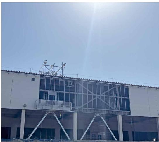
外構工事を早く進めることを目的に、外壁工事向けにP-UP工法ゴンドラを採用。従来より約90日工期短縮を可能にした。
