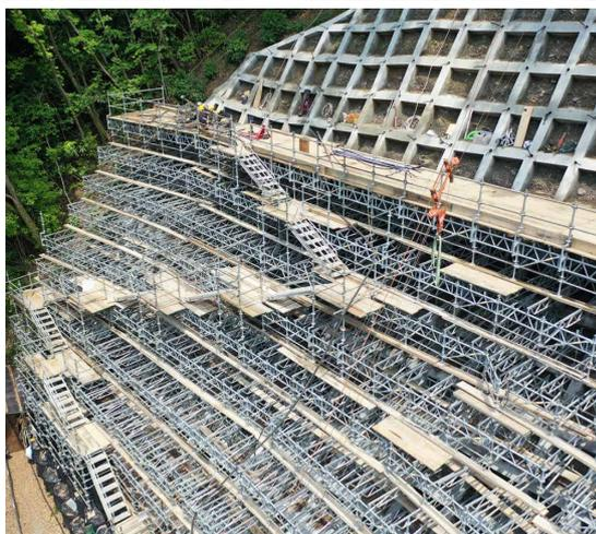
高低差20m程の法枠に鉄筋挿入工287本を施工する工事。県道と現場間に防護柵があり、特殊重機を設置しての削孔が困難なため、人力で運搬・組立が出来る法面マルチアングル工法を採用。簡単に組立ができ、作業効率の向上と工期の短縮を実現した。設置面積＝作業構台14段約1300空<sup>m</sup>。
