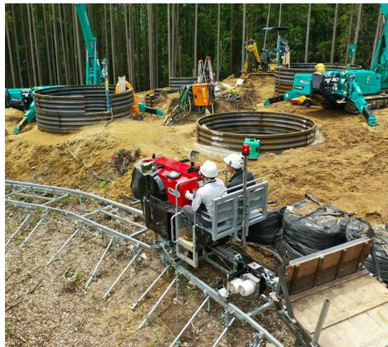
鉄塔工事の資材運搬と移動手段として、モノラックが活用。モノラックのレールの長さは7.6m。また、山道を昇降するモノレールの発着所として、法面マルチアングル工法2.4tが採用された。
