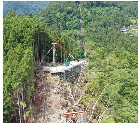
鉄塔建て替えのための資材を送る索道の発着所および車両の搬入、資材置き場として法面マルチアングル工法約4.5tを設置。
