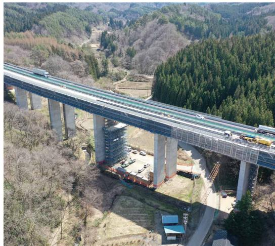
供用して35年経った八戸自動車道の浄法寺IC～一戸IC内の橋梁床版取替工事(写真は長流部橋)。クイックデッキは長流部橋上下線3597.4㎡沢内橋下り線4732.6㎡使用。日綜産業工事部が施工した。
