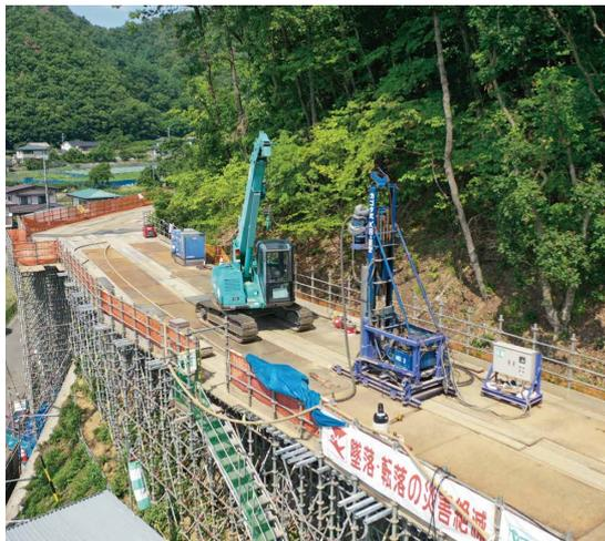
住宅街の裏山にある長さ84mの崩壊土砂防止柵工。高4約4mの支柱を36本打込むために法面マルチアングル工法を100t採用。構台のサイズは約2400空㎡。施工者からは「熟練度に左右されことなく計画図面通りに構台を作ることができ、経験が浅い若手技術者の活躍場面も増える。」と好評であった。
