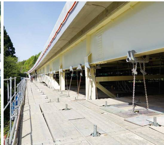
石川県と富山県を結ぶ北陸自動車道の櫛谷（橋橋長95m、鋼3径間ローゼ）にクイックデッキ1500㎡、3Sシステム102t採用。
