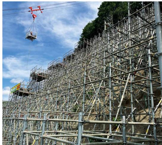
ダムの災害復旧工事。斜面对策としてアンカー工事を行なうための作業構台で法面マルチアングル工法370t以上納入。工期は数年間にも及ぶ東北地区で最大級の法面仮設工事である。
