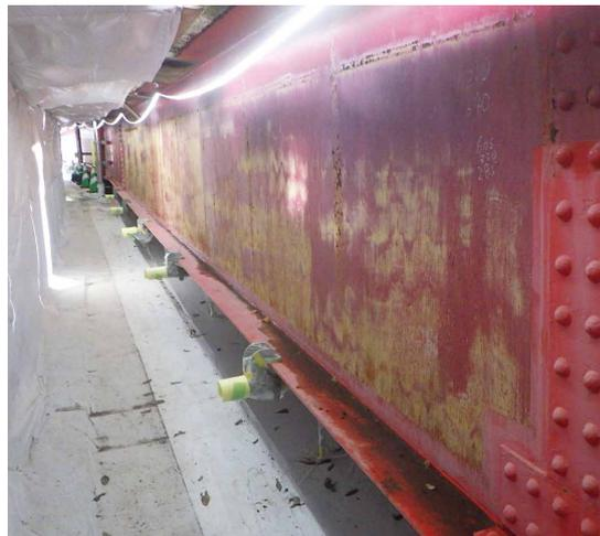
全長約60mの方丈ラーメン橋塗り替え塗装のため、クイックデッキを橋脚部に橋梁桁下にクイックデッキライトを設置。国土交通省の「橋梁工事における新技術の足場活用促進」の取り組みとして在来足場からクイックデッキに変更し、工期短縮に貢献した。
