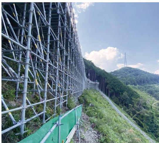
岐阜県発注の案件で、高速道路横の私有地斜面を掘削する為の重機構台として法面マルチアングル工法が約1,100空m<sup>3</sup>採用。2年前より着工しており、段ごとに構台を盛替えて掘削を行っている。掘削した土砂はモノレールによって下部まで運搬。
