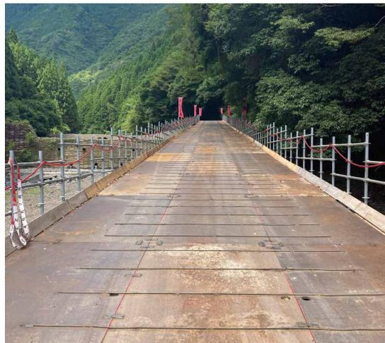
土砂崩れの災害復旧工事。現場へトラックなど搬入車両がアクセスするための約100mのスロープ構台として法面マルチアングル構台67tが納入された。
