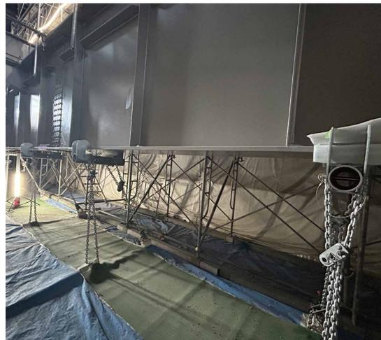
北海道新幹線札幌延伸工事に伴い、人の通行量が多い札幌駅構内にクイックデッキ144㎡設置。景観に馴染む見栄えのいいアルミデッキが採用された。
