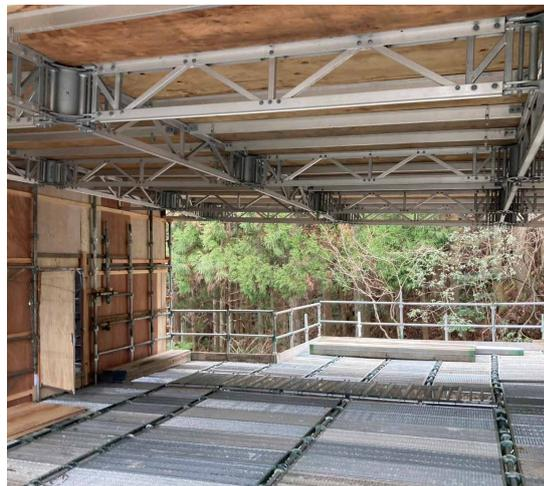
鳥取県八頭郡智頭町を走る国道53号線の黒尾峠にかかるうぐいす橋（ラーメン橋）の橋梁塗装工事。橋梁上部にクイックデッキライト（約600㎡）、橋梁下部にクイックデッキ（約180㎡）を設置し、施工中の安全性が高まった。
