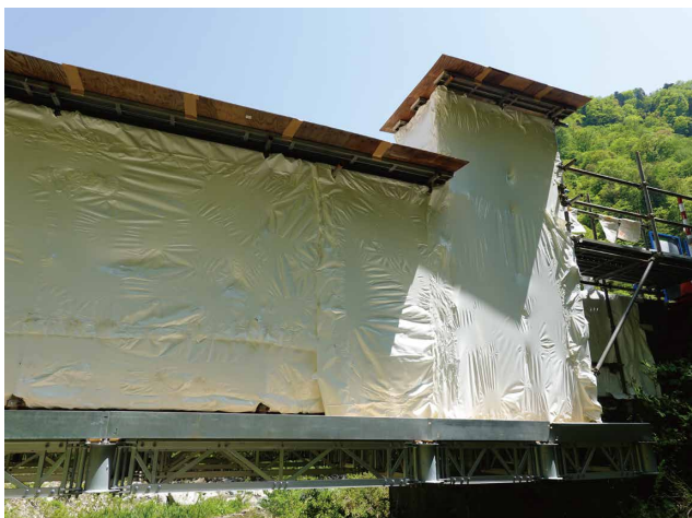
橋梁塗装工事 ▶ プラスト施工時の外部拡散防止対策にて使用 + 簡易クリーンルーム作成（富山）
