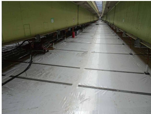
大型橋梁 ▶ 河川への漏水対策にて使用（東京）
