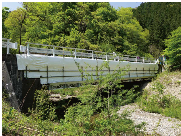
橋梁塗装工事 ▶ プラスト施工時の外部拡散防止対策にて使用 + 簡易クリーンルーム作成（富山）
