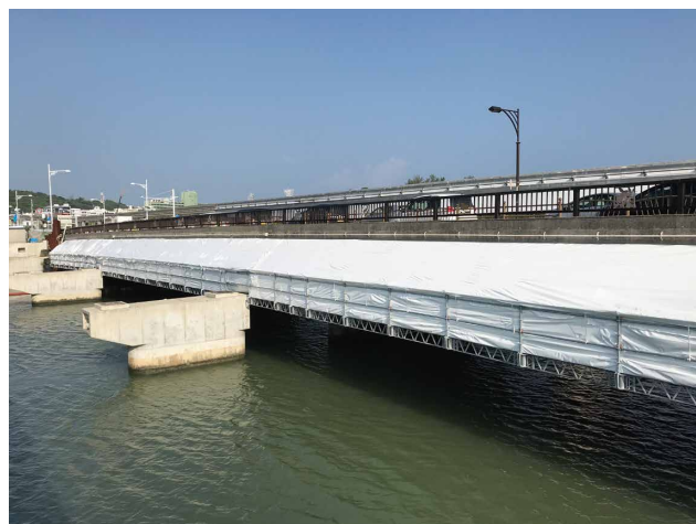
橋梁塗装工事 ▶ プラスト施工時の外部拡散防止対策にて使用 + 簡易クリーンルーム作成（富山）
