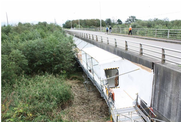
一般橋梁 ▶ 塗装塗替工事にて使用（北海道）
