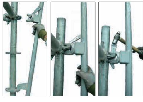
下部フックをフランジに差込み上部ヘッドをフランジに組付けケサビを打込む
