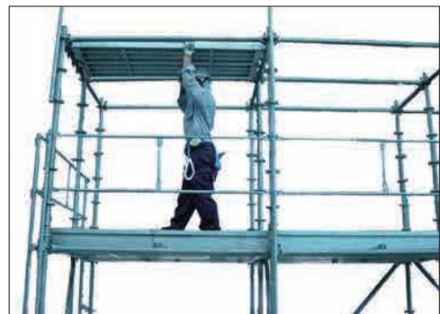
上層部へ作業床 (布板) 取付けて完了
