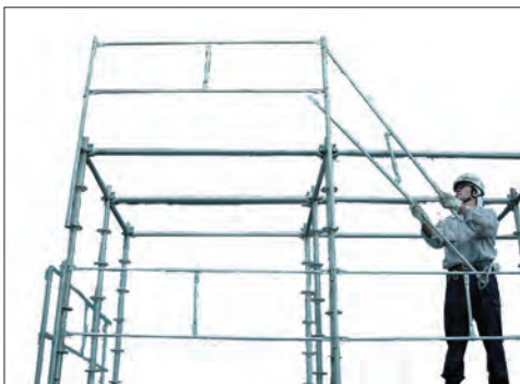
⑦から⑫までの繰り返しで他のスパンへ取付ける
