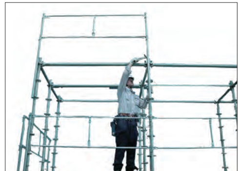
上部ヘッド部のクサビを打込み組立完了
