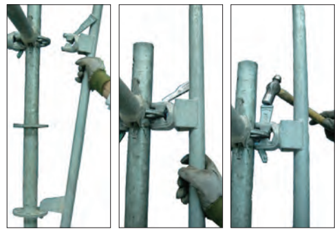
下部フックをフランジに差込み上部ヘッドをフランジに組付けクサビを打込む
