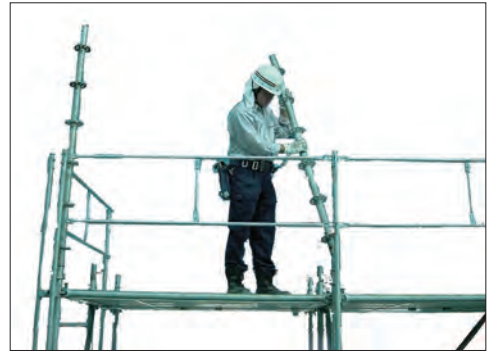
パーチカル (建地支柱材) の組立
