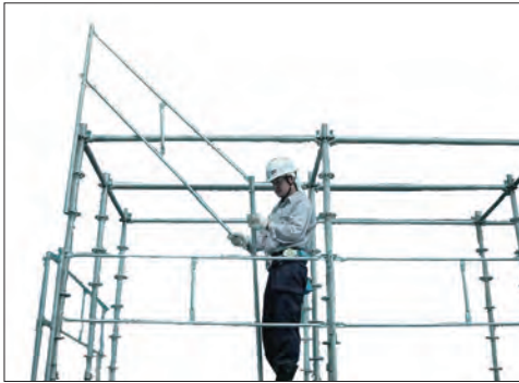
もう一方の手すり端部を支柱に取付ける
