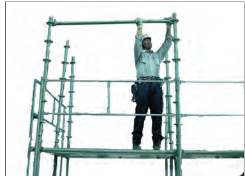
水平ソナル (水平材) の取付
