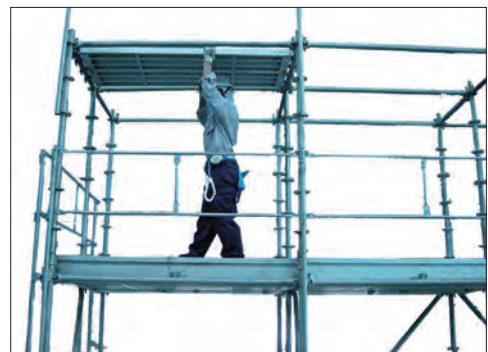
上層部へ作業床 (布板) 取付けて完了
