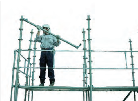
水平ソナル (水平材) の取付
