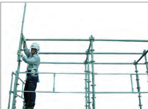
手すり支柱のパーチカルへの取付
