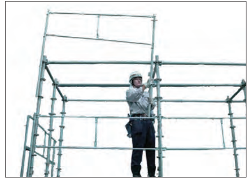
手すり取付け後、支柱下部を持ち上げる
