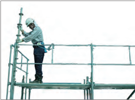
パーチカル (建地支柱材) の組立
