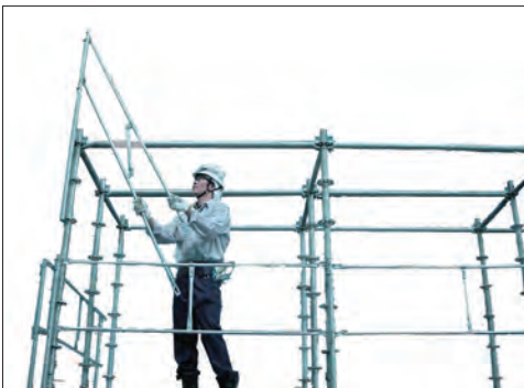
二段手すりを支柱に取付ける (約45°の角度にて)
