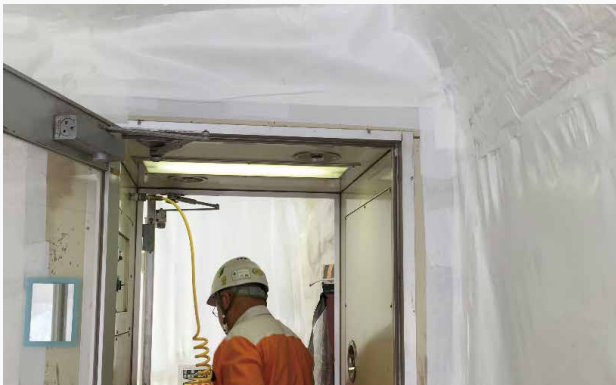
出入り口にエアシャワー付き集塵機を設置
