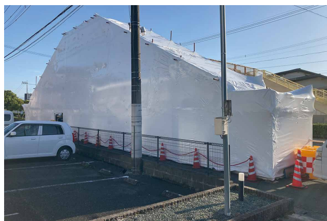
歩道橋階段部 ▶ 塗装塗替工事にて使用（熊本）
