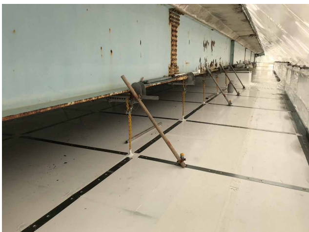
大型橋梁 ▶ 橋梁解体工事に於ける有害物質除去作業にて使用（沖縄）
