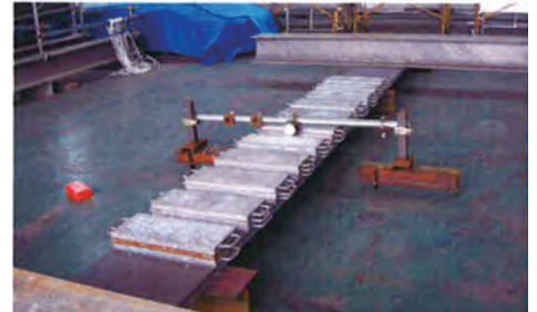
▼撓み試験状況
