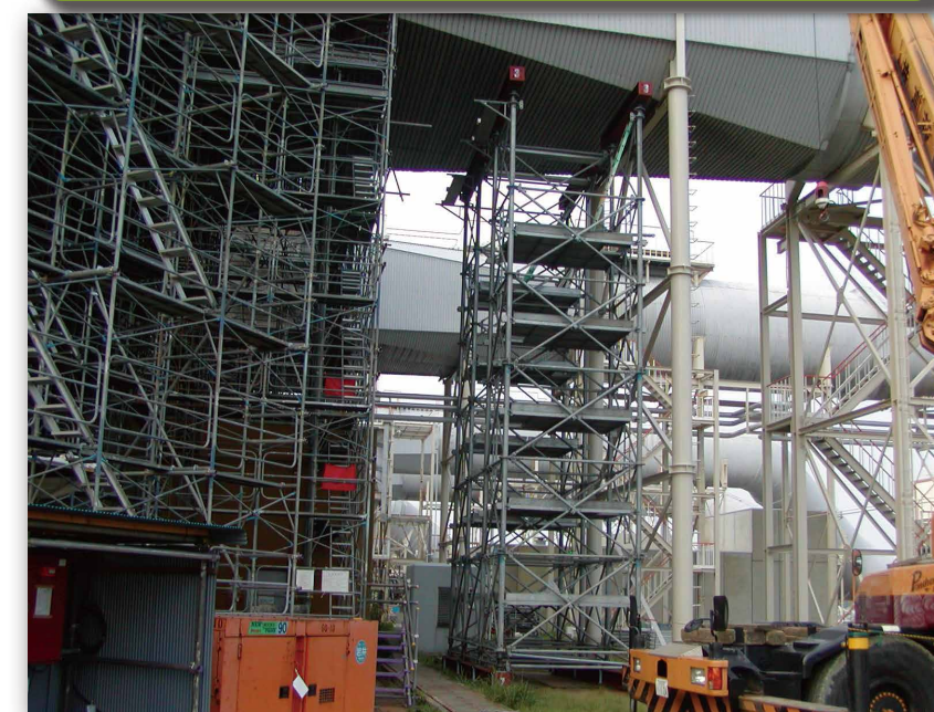
ダクト交換用架台設置
