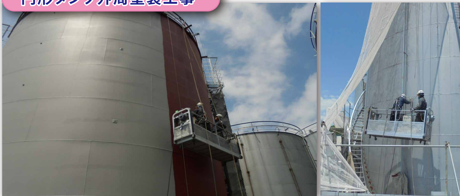
石油備蓄施設 円形タンク外周塗装工事
