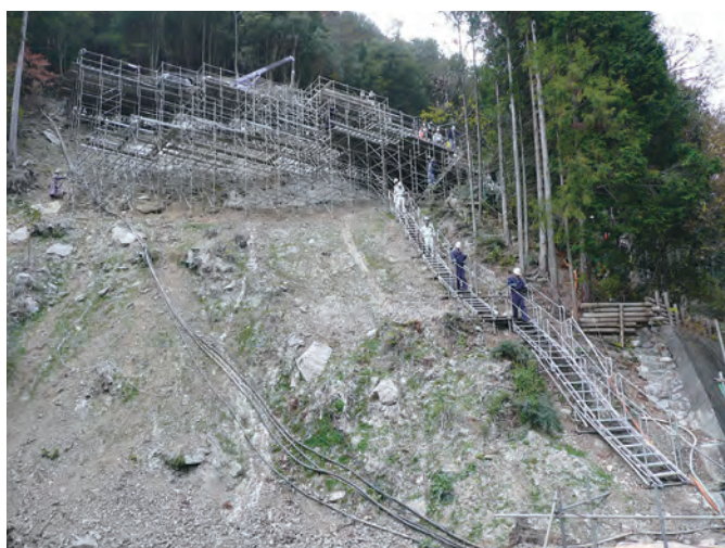
作業員の昇降用通路
