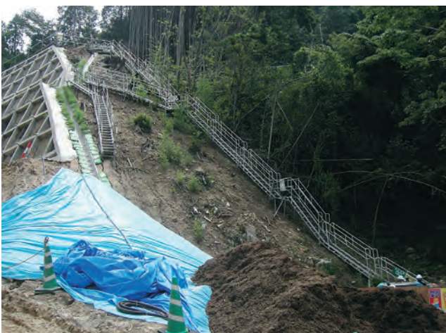
砂防流路工事(昇降及び作業足場)
