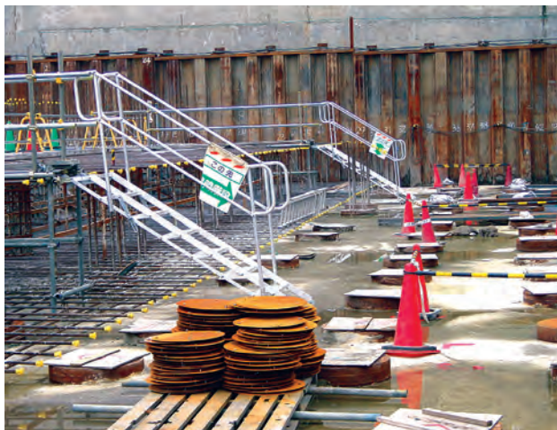
地足場より作業場への昇降設備
