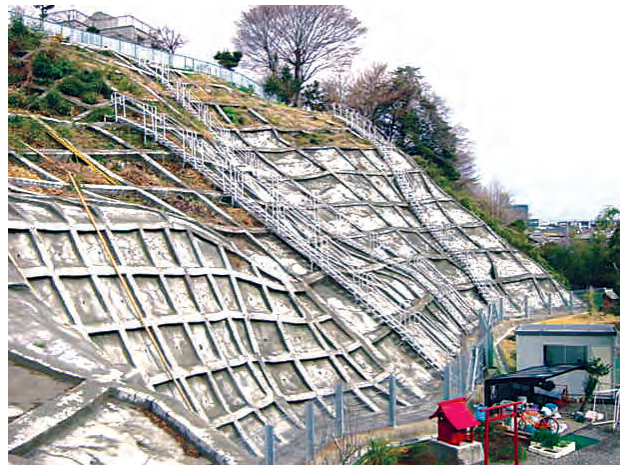
民家の裏山への昇降設備(常設例) 各地主用として4箇所設置
