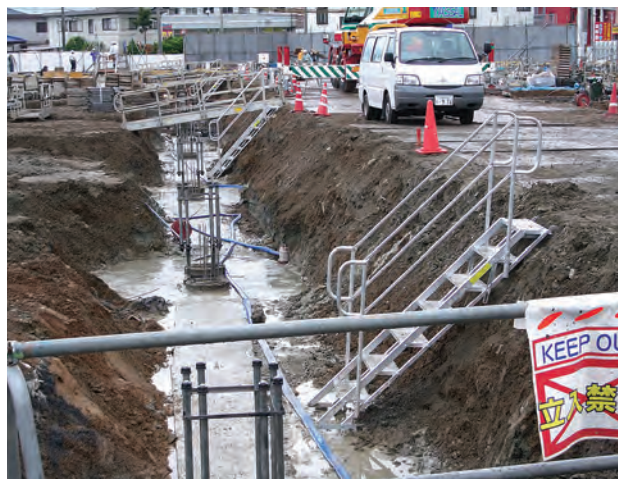
基礎工事の時の昇降設備
