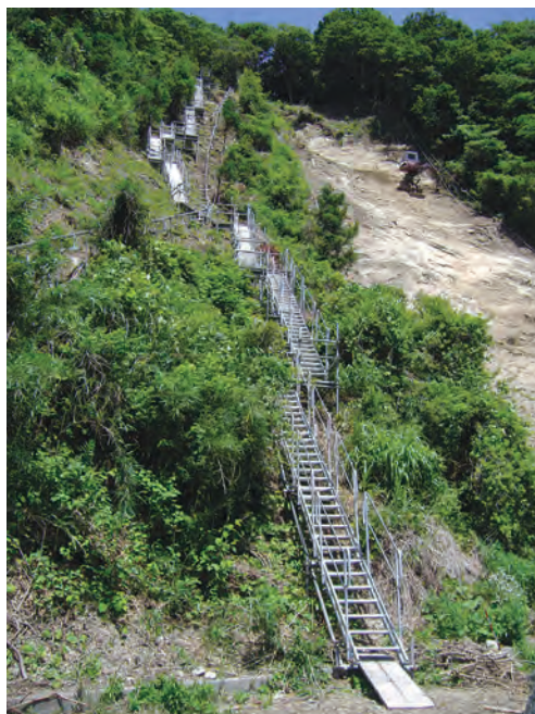
法面工事準備段階で使用
