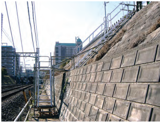
鉄道関係の保守工事用として使用
