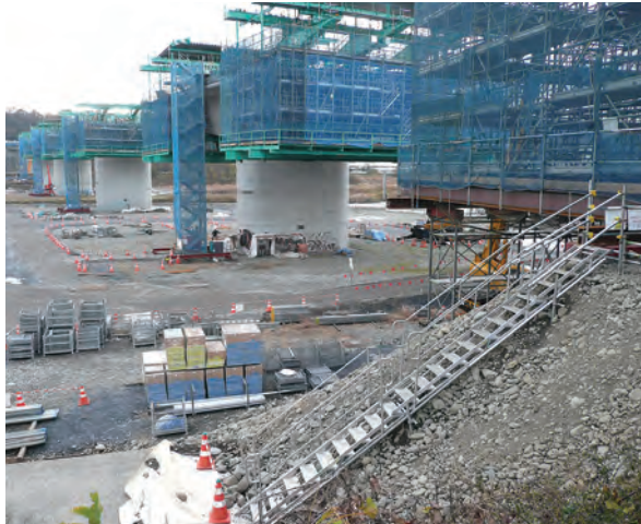
上部工工事の昇降用通路
