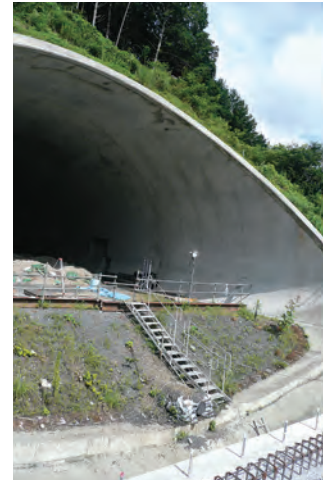
トンネル入口への昇降設備
