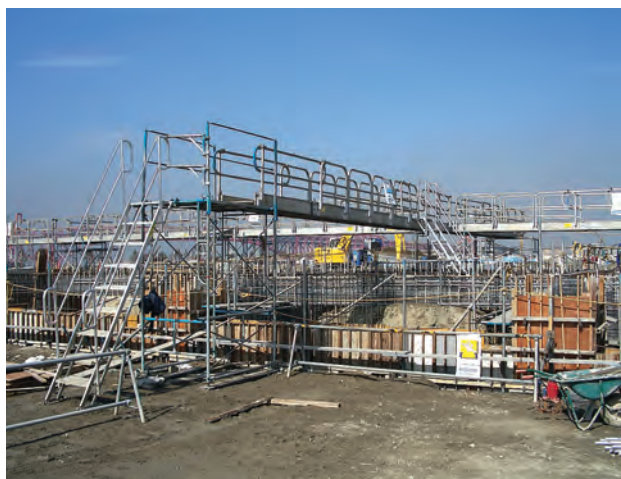
安全通路より作業床面への昇降設備
