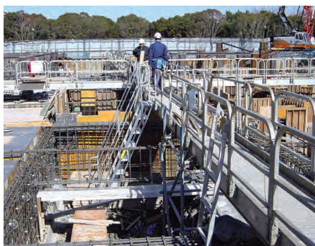
地中梁鉄筋を乗り越える為の使用
