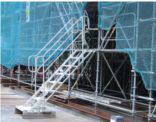
足場支保工への昇降用通路
