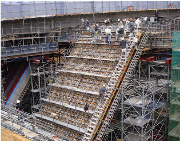
跨道橋架設の昇降設備
