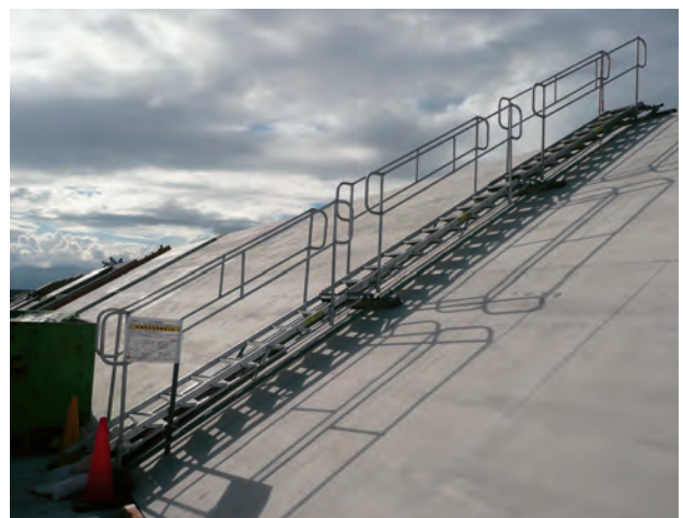
沿岸部護岸工事の昇降設備
