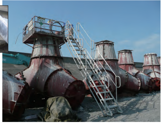
テトラポット製作用 昇降設備
