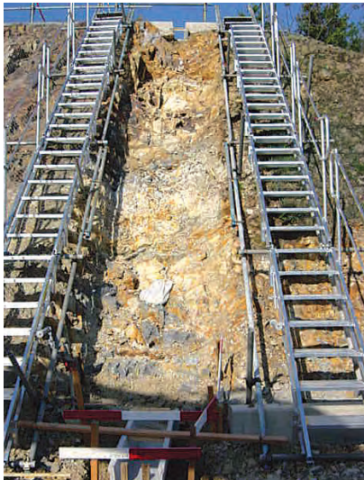
砂防流路工事(昇降及び作業足場)
