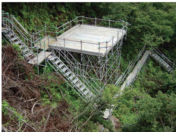
作業員の昇降用通路(踊場設置例)
