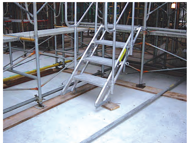
枠組足場(調整枠)用の昇降設備
