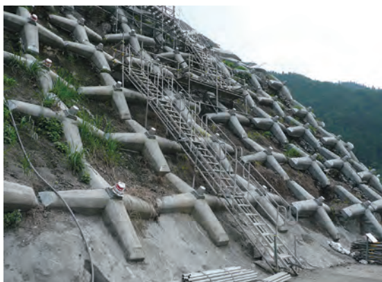
作業員の昇降用通路
