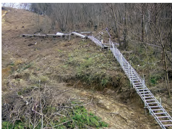
作業員の昇降用通路(組立状況)
