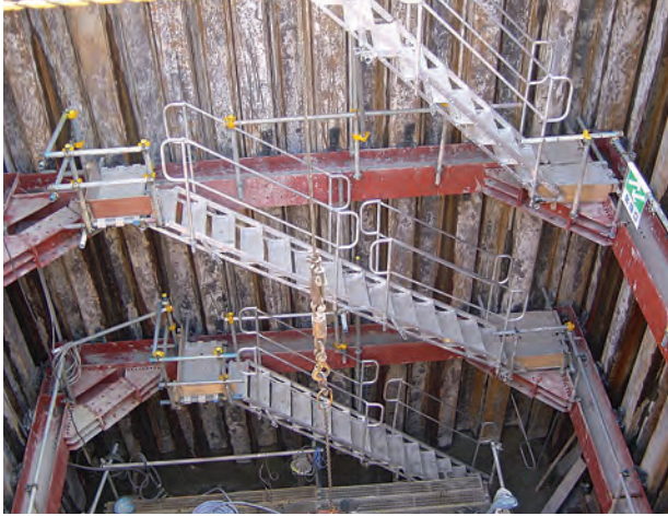
立坑工事での昇降設備
