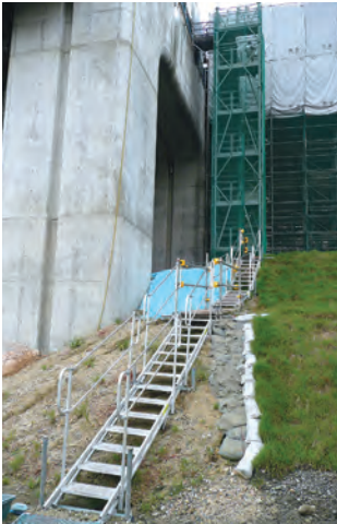
上部工工事の昇降用通路
