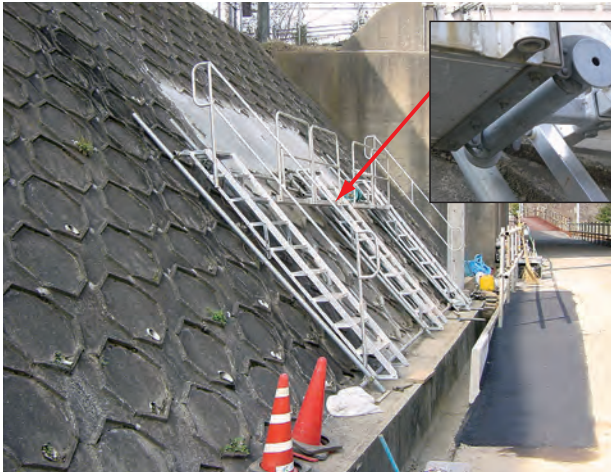
鉄道擁壁工事に使用(作業足場の設置例)
