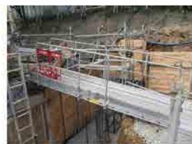
渡り機橋として使用
