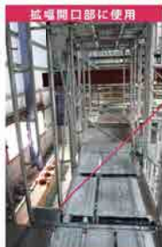
拡幅開口部に使用
