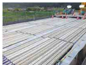
大型橋梁現場で使用
