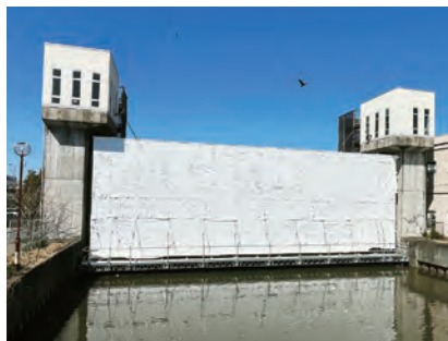
水門ゲート塗装塗替工事
