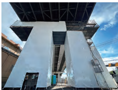
アスベスト飛散対策
