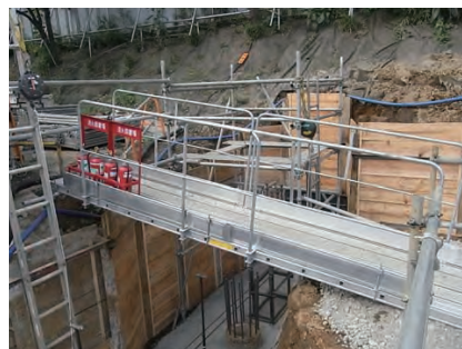
渡り栈橋として使用
