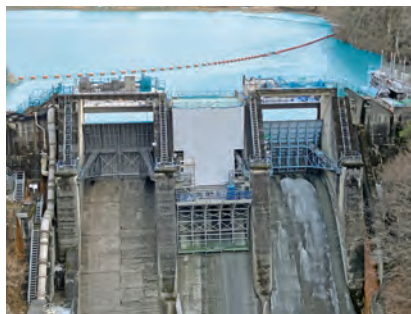
ダムゲート洪水吐改修工事
