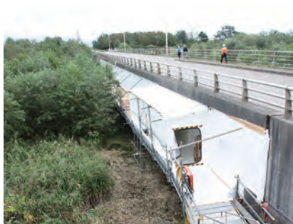
塗装塗替工事
