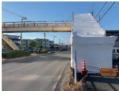
塗装塗替え工事
