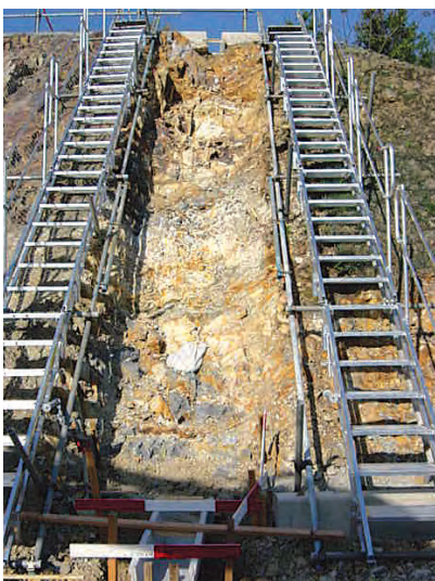
砂防流路工事(昇降及び作業足場)
