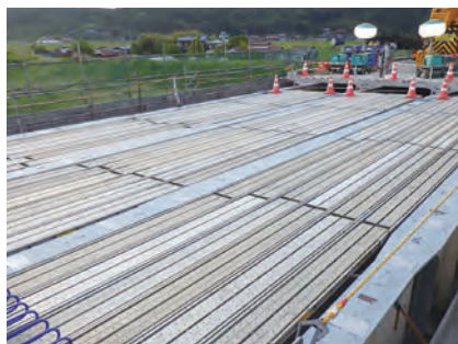
大型橋梁現場で使用
