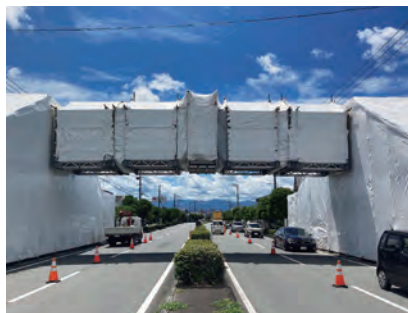
塗装剥離飛散防止
