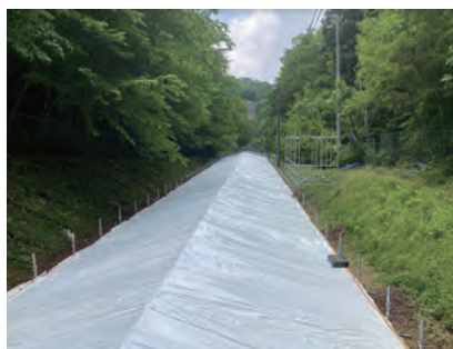
ブラスト時の雨漏り対策
