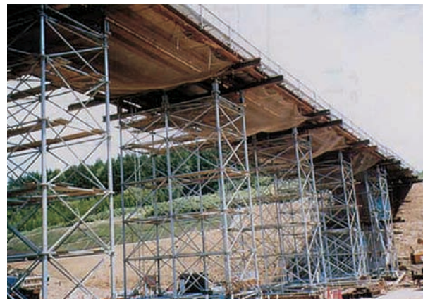
東栄橋工事（プレキャストセグメント工法）
