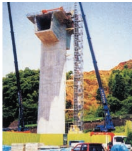
ハイビアーの現場 (エレベーターをセットして)
