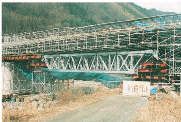
NSトラスの施工現場
