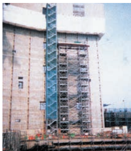
階高の有る建築現場に (エレベーターをセットして)
