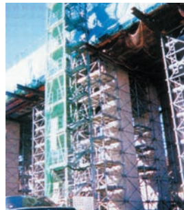
橋梁工事の現場
