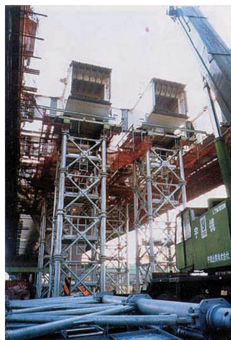
高速大宮線OM41工事（鋼橋）
