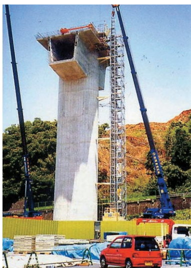
玉湯高架橋工事（エレベーター付・昇降用）
