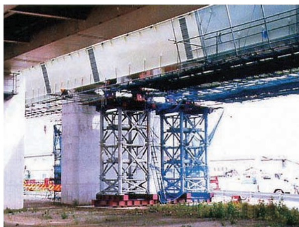
小櫃川橋梁上部工事（鋼橋）
