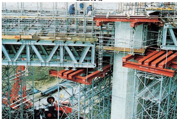
NSガーダーでの施工
