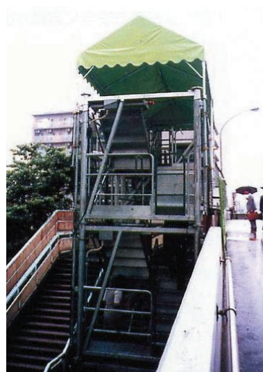
一号階段補修工事 （歩行者代替階段として使用）
