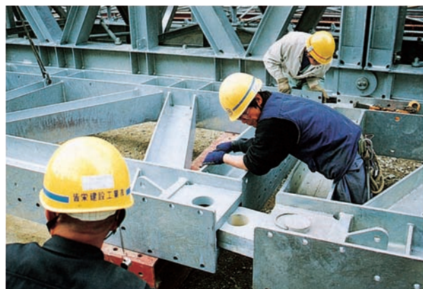
上弦材はリンクを差し込んで、ジョイントピンとピンキャップにて固定
