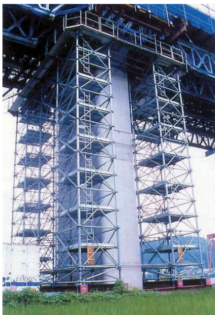
戸田高架橋工事（PC橋）
