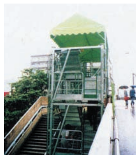
階段の修繕工事に
