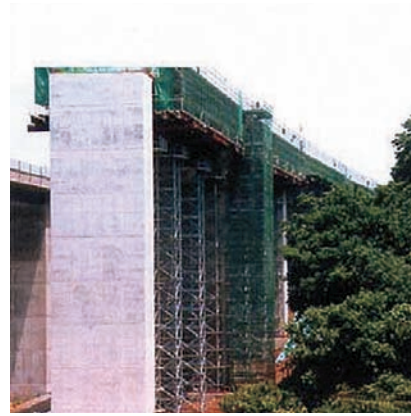
古川橋（PC上部工）
