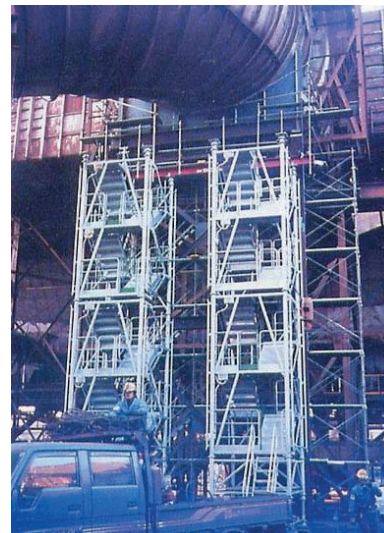
ダクト改修工事（支保工兼用）
