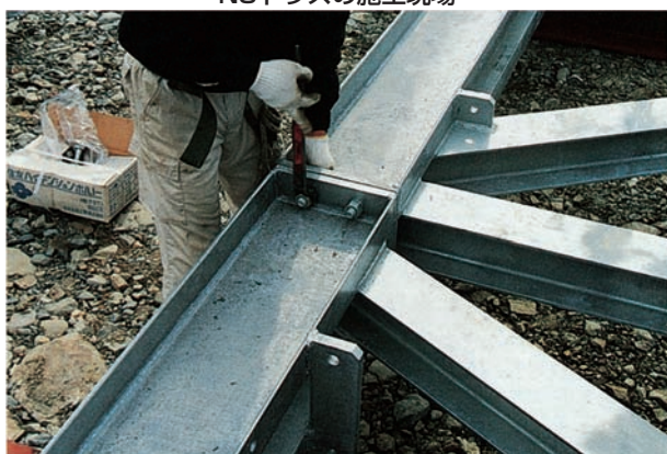
上弦材はボルトにて固定
