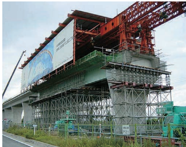
村東第2高架橋工事
