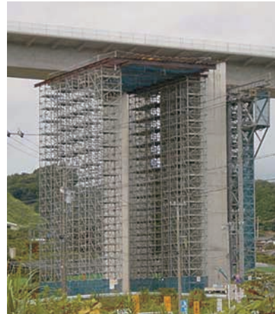
大平高架橋工事
