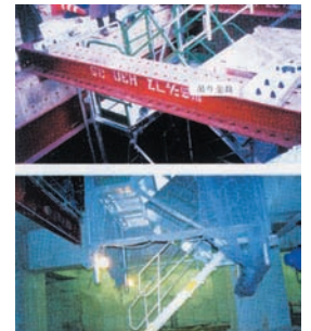
地下工事に吊り階段として
