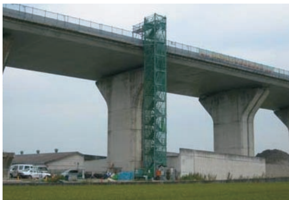
大和御所道路工事（上部への昇降用）
