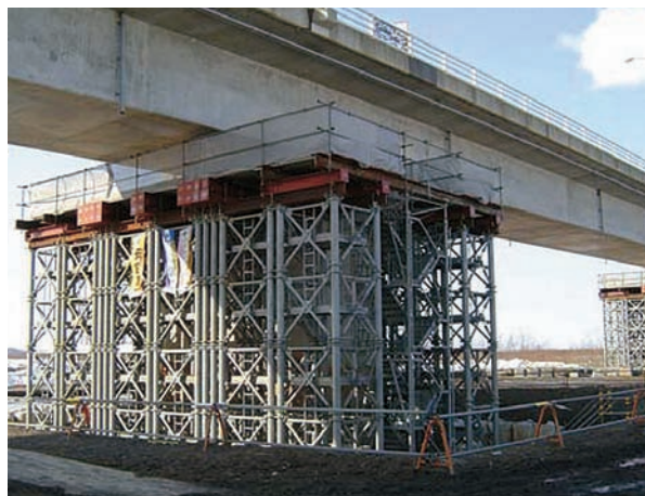
十勝河口橋復旧工事
