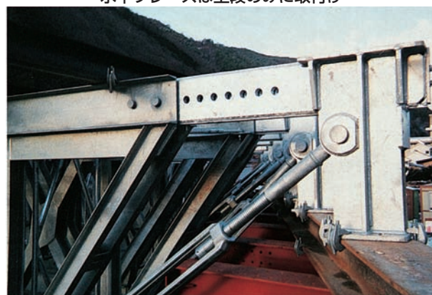
ターンバックルはジョイントピンにて固定
