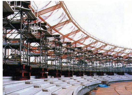
柏の葉サブスタンド工事
