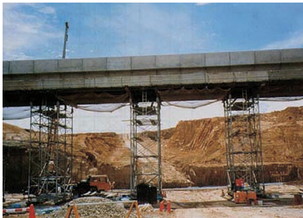
東栄橋工事（プレキャストセグメント工法）
