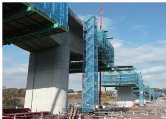
さがみ縦貫相模川渡河橋
