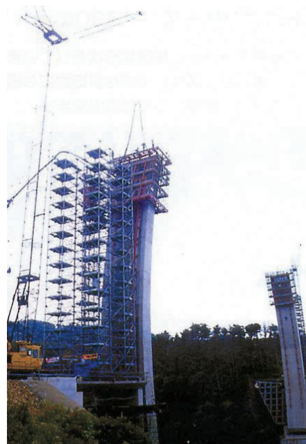
三貫目大橋工事（PC上部工）
