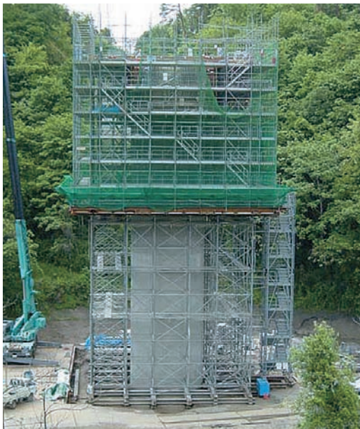
阿武隈大橋工事
