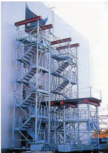
製薬工場新築工事（機械搬入構台）
