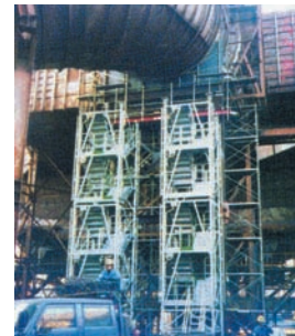
各種修繕工事に
