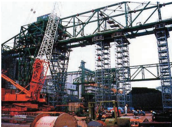
東洋埠頭（橋型クレーン式アンローラのトラス受け）
