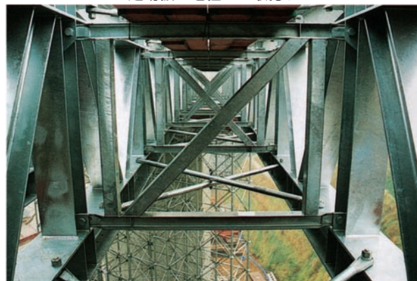
水平ブレースは上・下段に取付け
