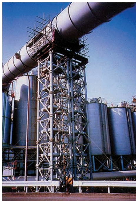
セメント工場パイプ設置工事
