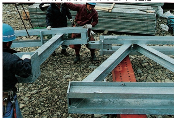
下弦材はジョイントピンにて固定
