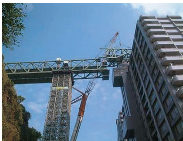
ホテル ブリッジ解体工事
