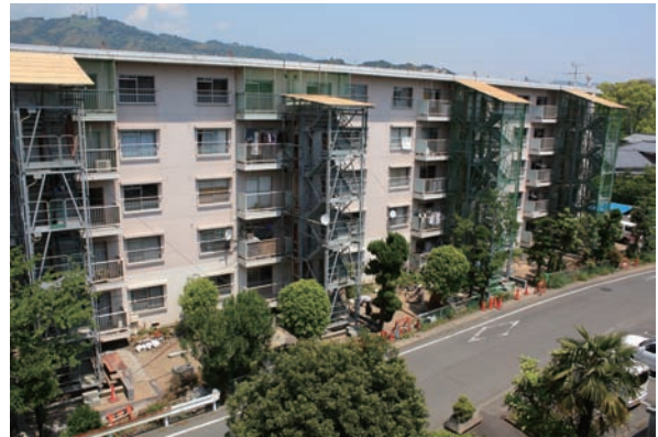
団地エレベーター設置工事前仮階段
