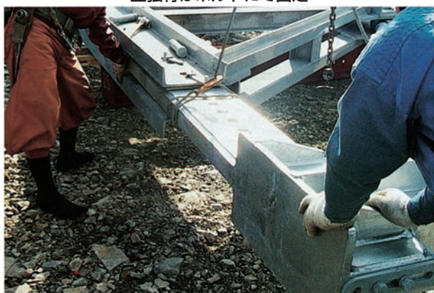
支持フレームは調節ピンにて固定
