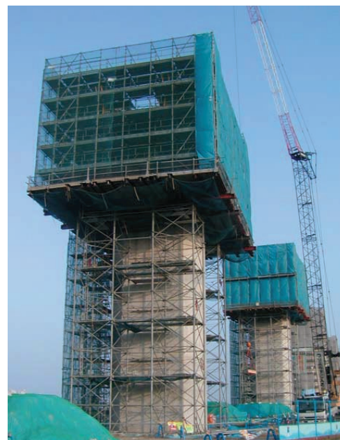
伏木富山港東西線工事
