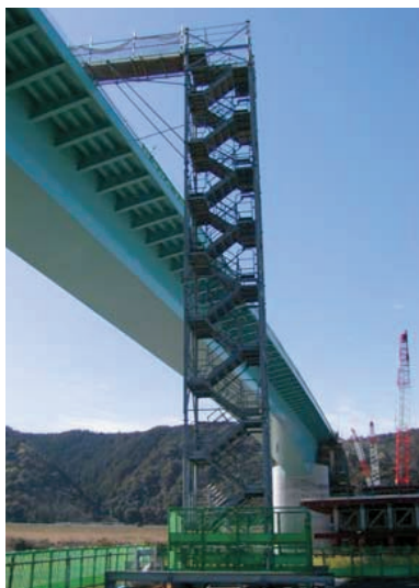
新四万十大橋工事（昇降用）
