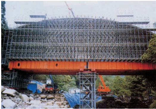
大妻籠橋工事（アーチ橋・下部に土木、上部は3Sオクタゴンを使用）
