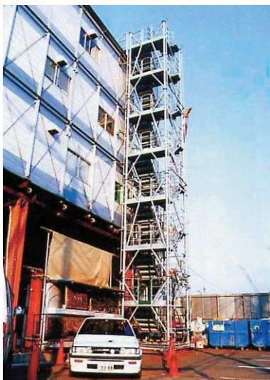
さいたまアリーナ新築工事
