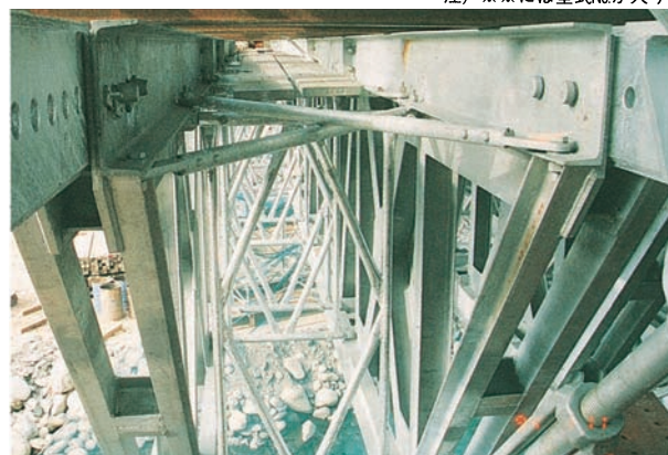
水平ブレースは上段のみに取付け
