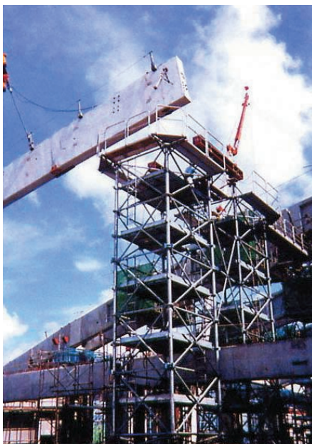
空港ターミナルビル（PC梁受け）
