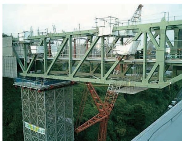
ホテル ブリッジ解体工事
