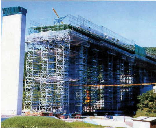
西ノ川橋工事（高さ25m上部工工事）
