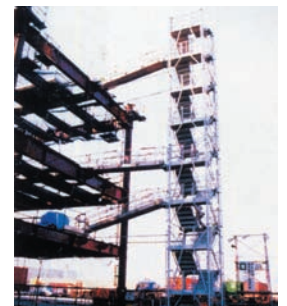
躯体より離れた階段として
