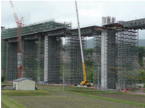
伊南バイパス1号橋
