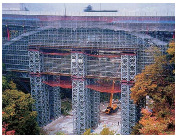
駒沢橋上部工補強工事
