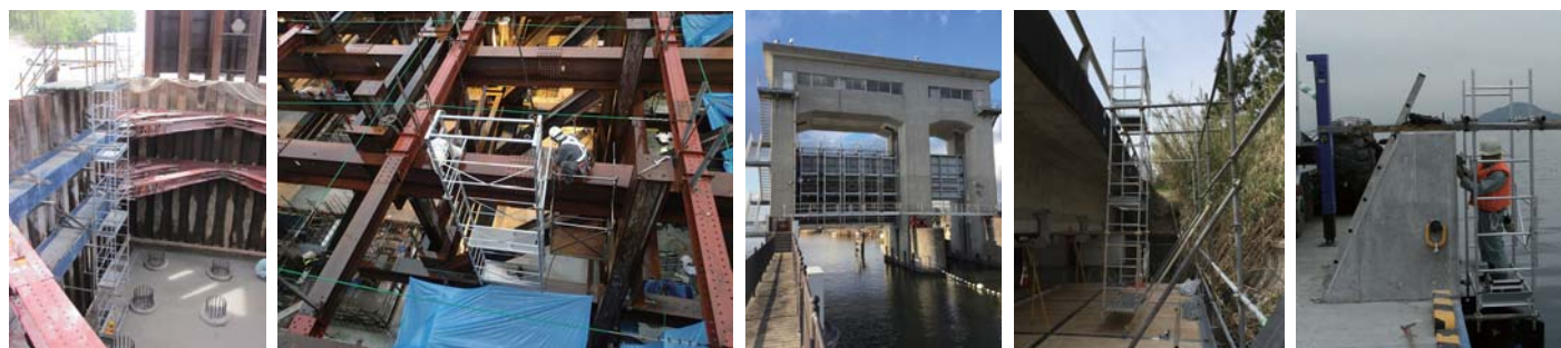
橋梁下部工工事
