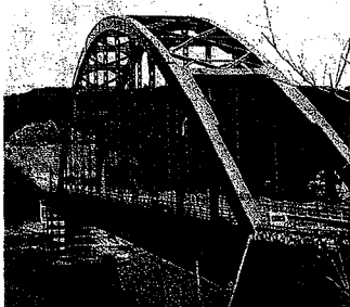
クイックデッキを 設置した頭ヶ島大橋
