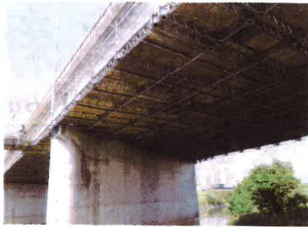
採用されたクイックデッキ (宇治川大橋)
