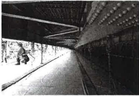
広島県北の庄原市東城町で西日本高速道路中国支社が進める「中国自動車道青津橋補修工事(施工Ⅱ三井住友建設・馬場則
