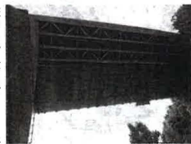
クイックデッキの設置状況
