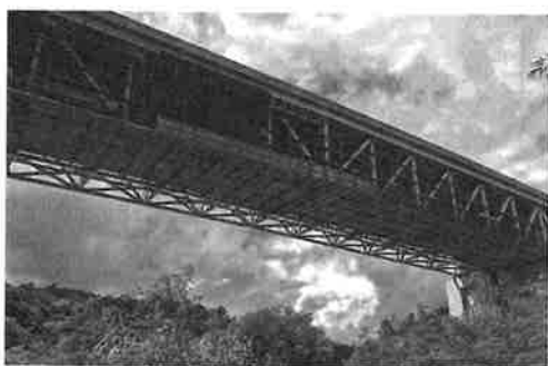
福地川橋の架設状況
