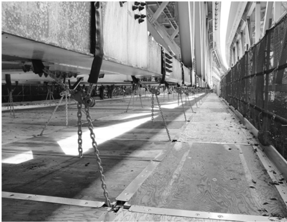
2.5mピッチで設置された高強度チェーン (提供：日綜産業)
