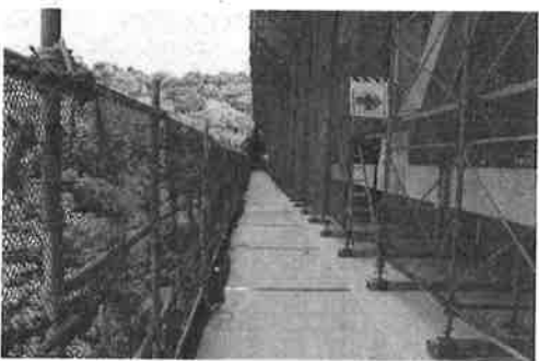
架設された福地川橋内部の様子
