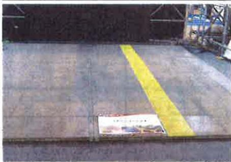
ーム改良工事などの仮覆工で首都圏を中心に全国約200現場で採用され、現在ではJR京浜東北線のホームドア工事でも活用されている。これまでの工法より作業量の削減につながり、レンタル品のため廃材も大幅に減らすことが
