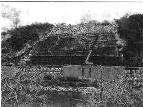
同工事は、県道・東和薄衣線沿いの登米市東和町錦織地内にある傾斜地がたびたび崩落していたことから、恒久的な対策を講じる。概要は、施工延長76・2㍍、吹付砕工4314平方㍍、足場工615
